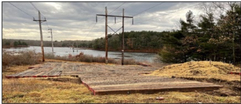
Esteras de madera (colocación)
