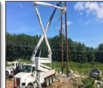
Camión grúa con cesta
