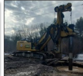
Equipo de perforación
